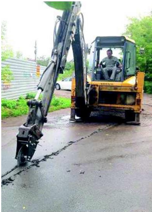
3.11 - сурет – VolvoBL – 71 plus тиегішті-экскаватордағы НДМ-4 дискілі пышақ жабдығының жұмысы
